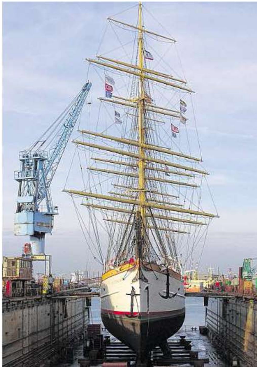
Im Bredow-Dock in Bremerhaven: Das „Schulschiff Deutschland“ bekommt ein Gürtelband auf Höhe der Wasserlinie und Stahlpflaster am Unterwasserschiff.
