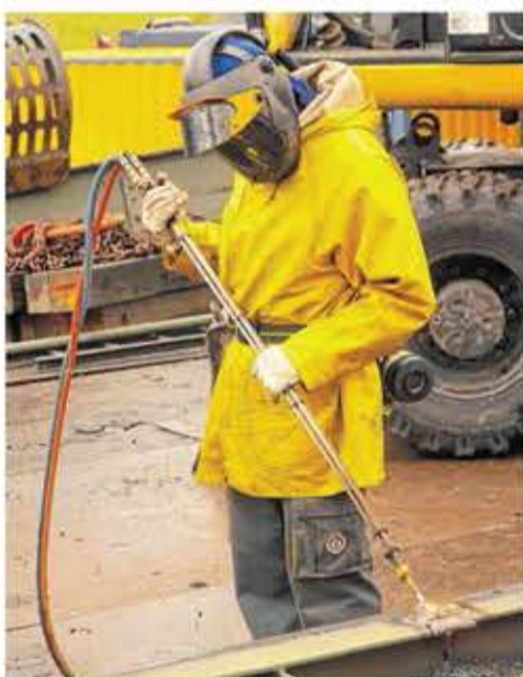
Mit Schneidbrennern wird den genieteten Konstruktionen zu Leibe gerückt.
