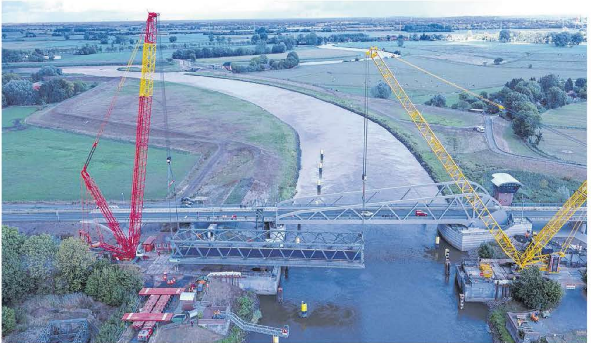
Im Abendrot lässt die Baufirma Tiesler das Geschehen rund um die Huntebrücke von einer Drohne fotografieren.
