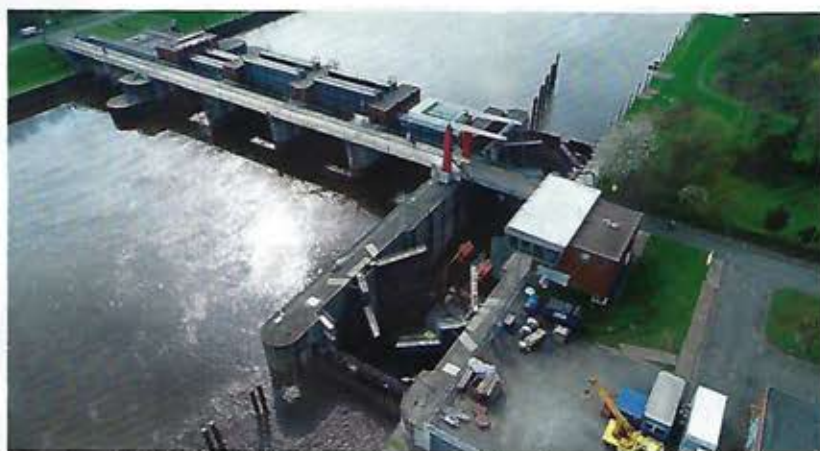
Kein Durchkommen mit stehendem Mast: Den ganzen April hindurch dauerten die Bauarbeiten an der Schleuse im Lesumsperrwerk an – länger als angekündigt. (Fotos: Kölling)
