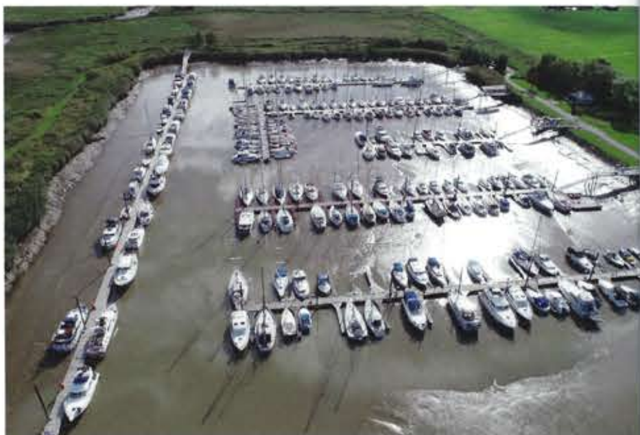
Die vorausgegangenen Weservertiefungen hätten zu massiven Aufschlickungen im Hafen von Nordenham geführt. Diese Schäden müsse der Staat erst einmal beheben, finden die Wassersportler. (Fotos: Kölling)
