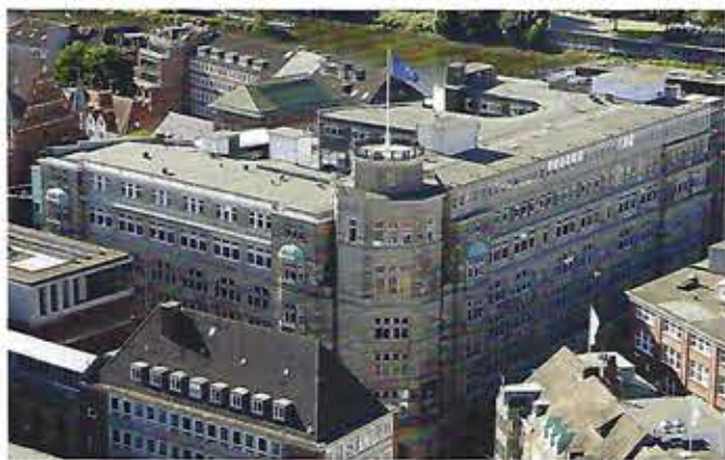
Stattliches Gebäude, exponierte Lage: Die Baumwollbörse überragt heute noch Schütting, Parlament und das Bremer Rathaus.
