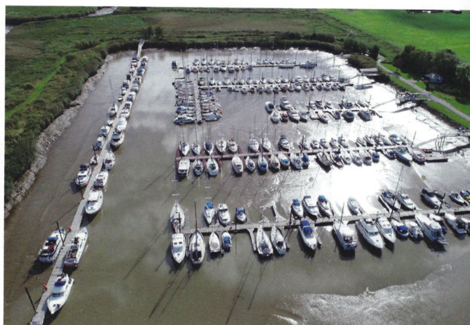
Die vorausgegangenen Weservertiefungen hätten zu massiven Aufschlickungen im Hafen von Nordenham geführt. Diese Schäden müsse der Staat erst einmal beheben, finden die Wassersportler. (Fotos: Kölling)
