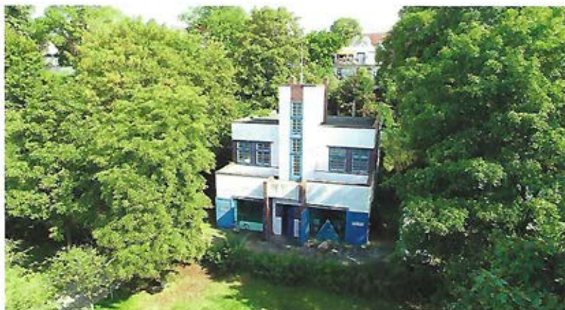
Das ehemalige Gebäude des Vegesacker Ruderverein ist eines der wenigen Bremer Zeugnisse der Bauhausarchitektur.
