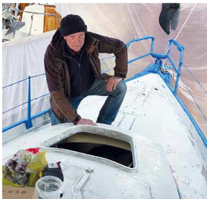
Ortstermin: Freund und Bootsbaumeister Ralf Weise treibt es beim Begutachten der Kölling'schen Baustelle die Falten auf die Stirn.
