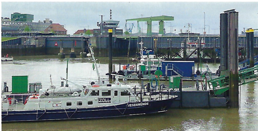
Bremsklotz Bauarbeiten: Noch bis Ende des Jahres dauern die Arbeiten an der kleinen Kammer der Fischereihafen-Doppelschleuse an. Sportbootfahrer müssen in dieser Zeit viel Geduld aufbringen. (Foto: Kölling)
